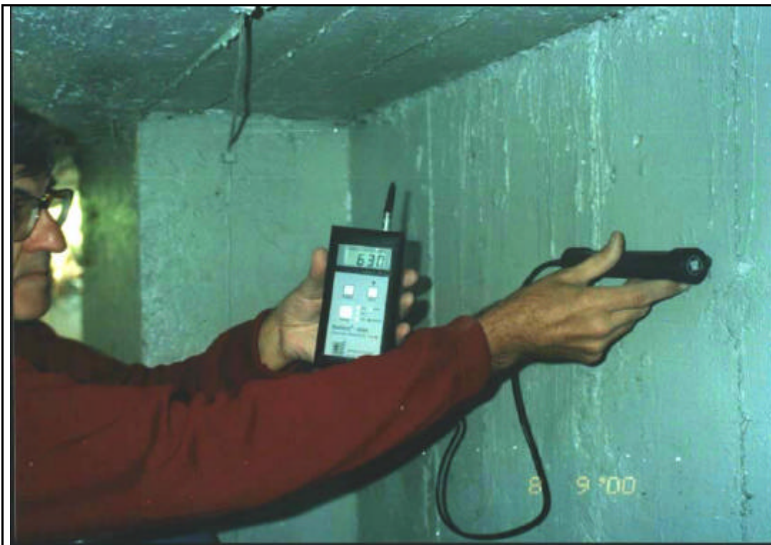
Fig. 5 - Misura della resistività del calcestruzzo. Nella foto, in alto, è visibile il cavetto collegato ad un elettrodo situato nella testata della trave.
