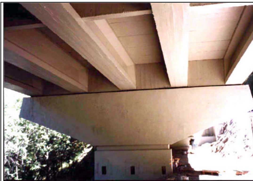
Fig. 6 - Un dettaglio dell'intervento completato
